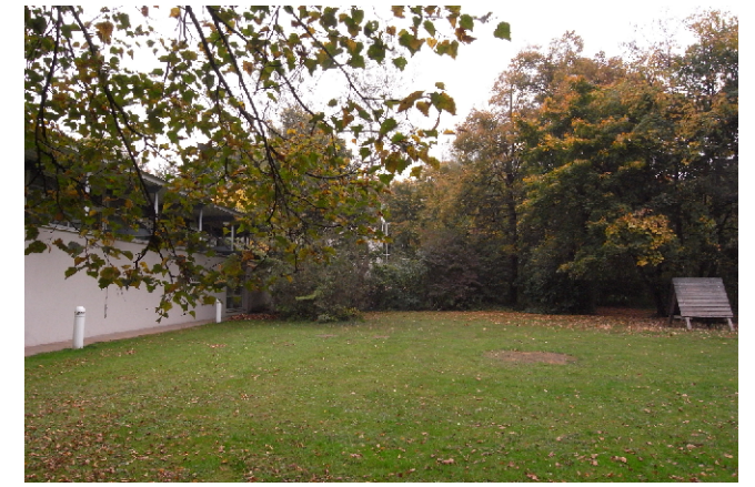
Vista façana posterior poliesportiu des del camí d'accés
